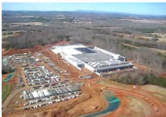
アップルのノースカロライナの巨大データセンター
