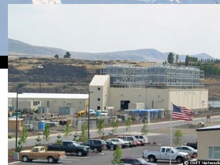
Googleの最初のデータセンター
