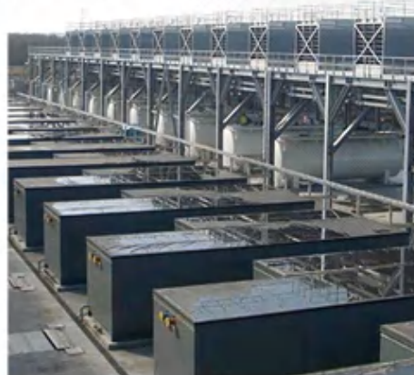
グーグルのコンテナ型データセンター
