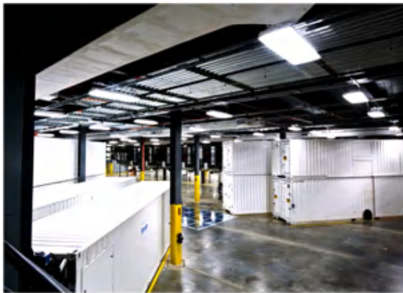
マイクロソフトのシカゴのデータセンター
